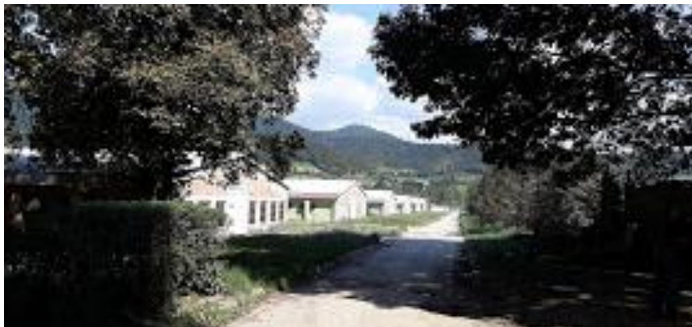
Slika 6. Farmski kompleks za uzgoj peradi teške linije BROVIS d.d. Visoko
